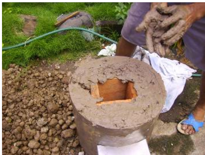
Relleno de barro de 1" de espesor para sellar perdida de calor
