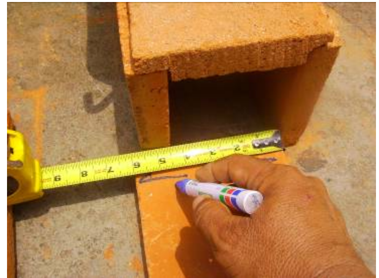
Paso 3: La base o sea una mitad de ladrillo se debe ajustar a la medida de la entrada del codo
