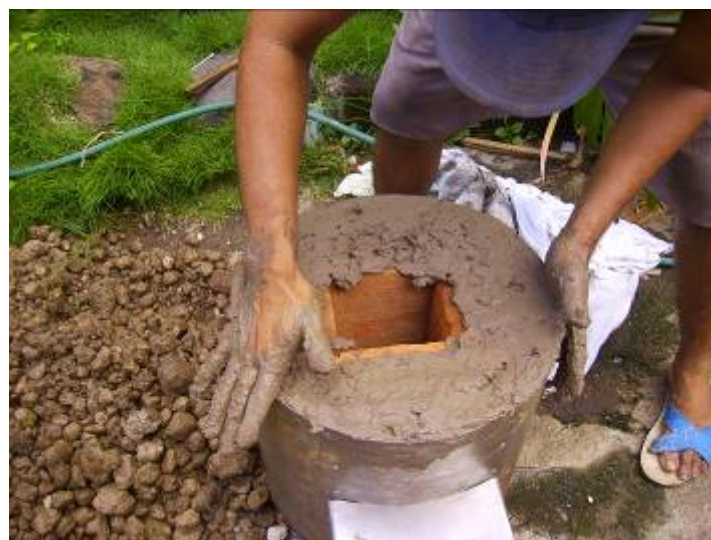
Relleno de barro de 1" de espesor para sellar perdida de calor
