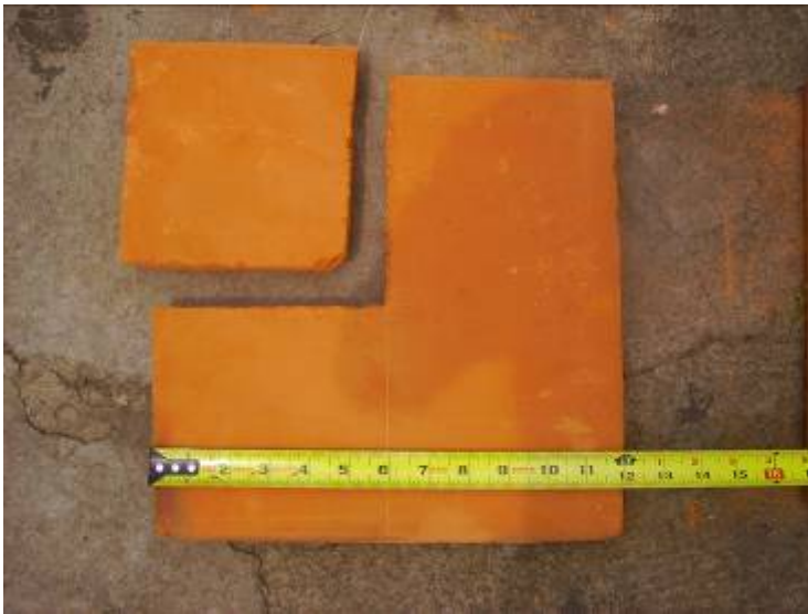
Paso 1: Corte de ladrillo en forma de L (medida de ladrillo es de 12"x12")
