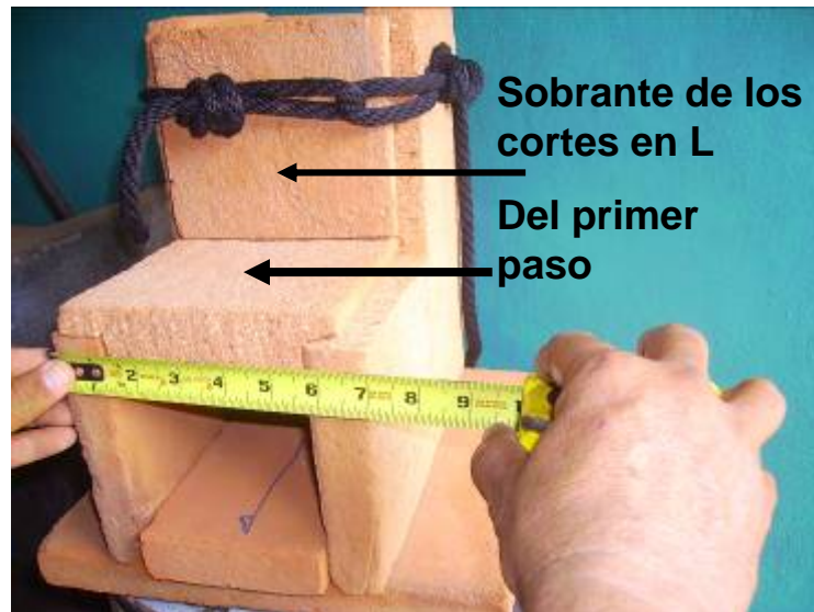
Fig. A. las piezas indicadas por las flechas son los sobrantes de los cortes en L con un ligero saque para soportar el relleno
